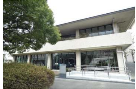
東京工業大学 国際交流会館本館
